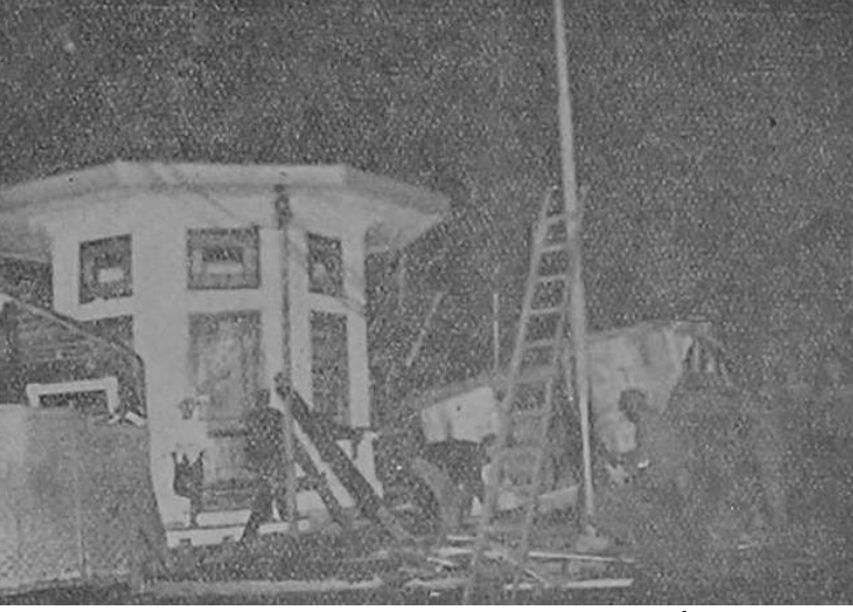
Karaköy Köprüsü'nün her iki başındaki mürûriye kulübeleri, görevlilerce yıkılırken...
